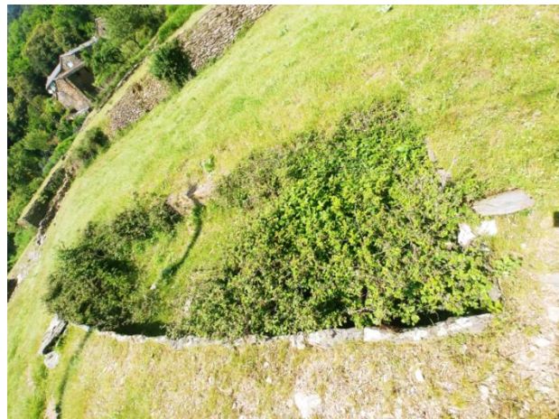
Aménagement en pierres en parcelle C313. Source : Photo prise lors de la visite du 5 Juin 2024
