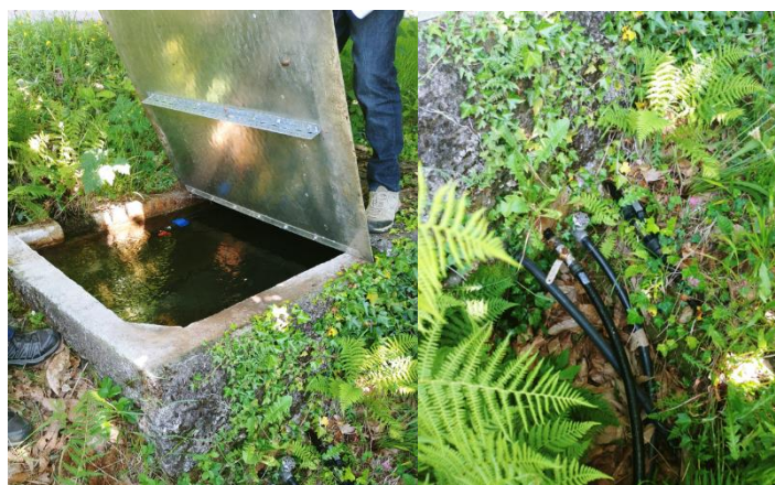
Réservoir d'eau en parcelle C303. Source : Photos prises lors de la visite du 5 Juin 2024
